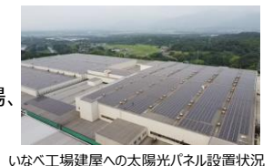
いなべ工場建屋への太陽光パネル設置状況
